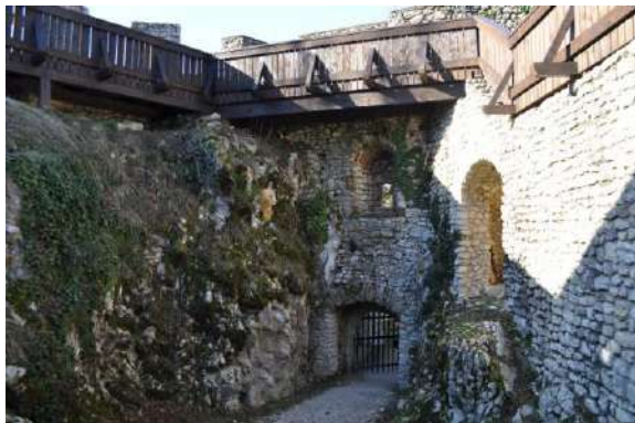
Slika 35: Notranjost obnovljenega gradu, slikala Ana Planko
