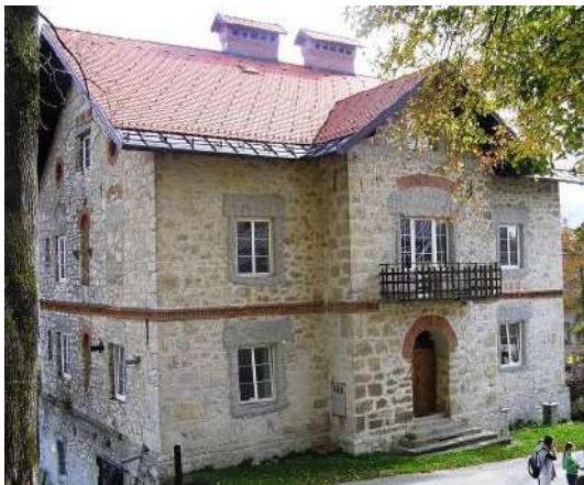
Slika 37: Obnovljena graščina , slikala Ana Planko
